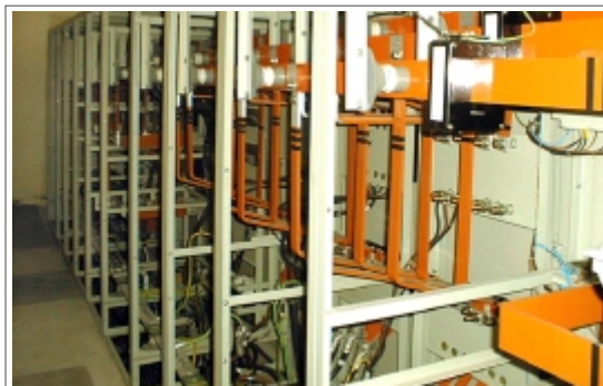
USPOŘÁDÁNÍ PASOVIN ROZVADĚČE 2 x 1000 A
