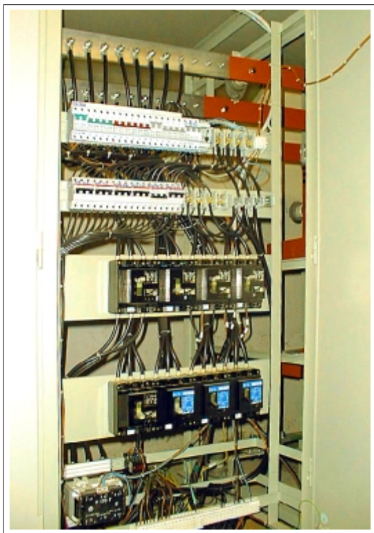
USPOŘÁDÁNÍ PŘÍSTROJŮ V ROZVADĚČI
